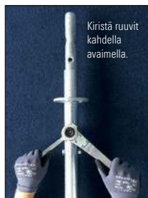
Kuva 32: Kiristä mutterit työkalulla.
