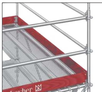
Kuva 52: Jalkalistojen asennus kulmaan
